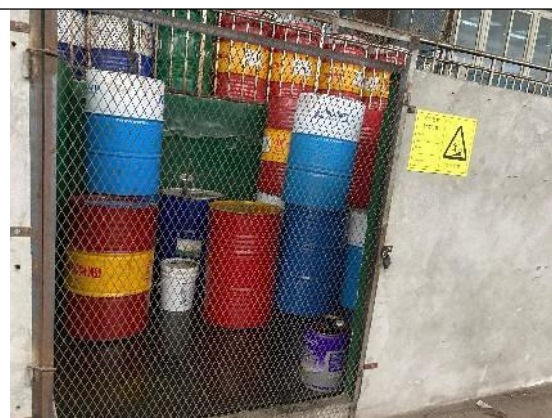
危险废物贮存间及危废桶标识标牌
