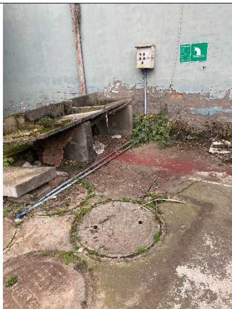
生活污水排放口
