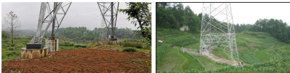
图 5-1 不等高与铁塔长短腿基础现场图
