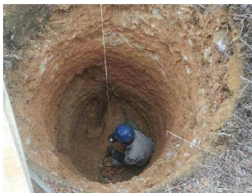
人工基础开挖
